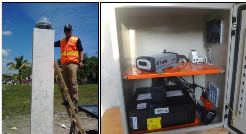
*Trabajo terminado. Izquierda: columna y antena. Derecha accesorios de la caja metálica (GPS, UPS, estabilizador, transformador, ventilador, etc.).*
