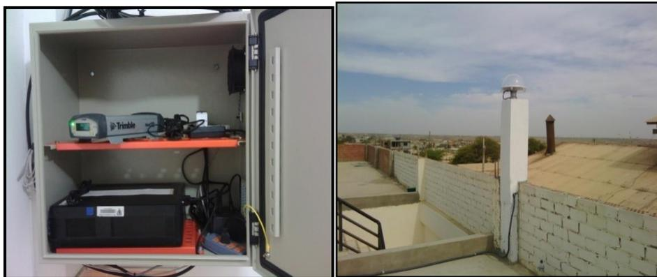
*Caja metálica con los accesorios de la estación: estabilizador, transformador SUPPLY, UPS, GPS. Vista de la antena GNSS.*
