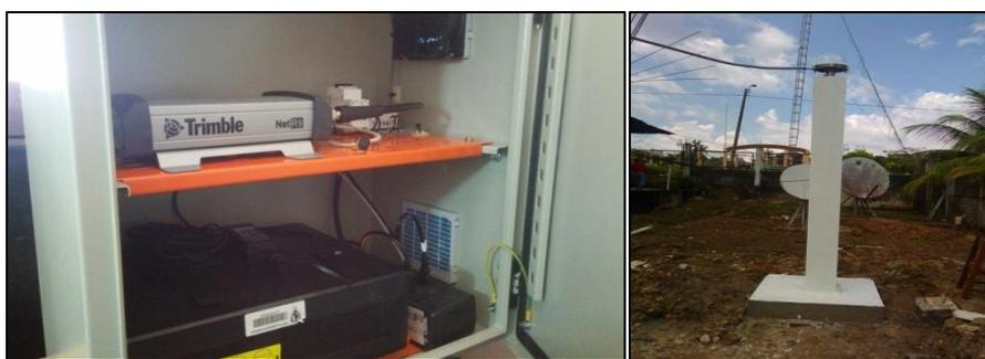
*Trabajo terminado. Izquierda: Receptor GNSS, UPS, estabilizador y transformador SUPPLY en el interior de la caja metálica. Derecha: Columna de 2.67 m de alto por 30 cm de ancho.*
