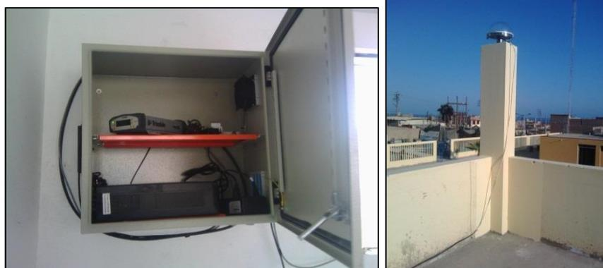
*Trabajo terminado. Izquierda: accesorios de la caja metálica (GPS, UPS, estabilizador, transformador, ventilador, etc.). Derecha: columna y antena.*
