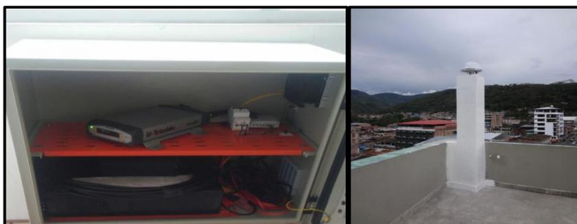
*Trabajo terminado. Izquierda: accesorios de la caja metálica (GPS, UPS, estabilizador, transformador, ventilador, etc.). Derecha: columna y antena.*
